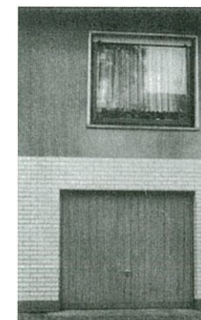
Nachträgliche Garageneinbauten in vorhandene Hauptgebäude sind gestalterisch nicht erwünscht.
