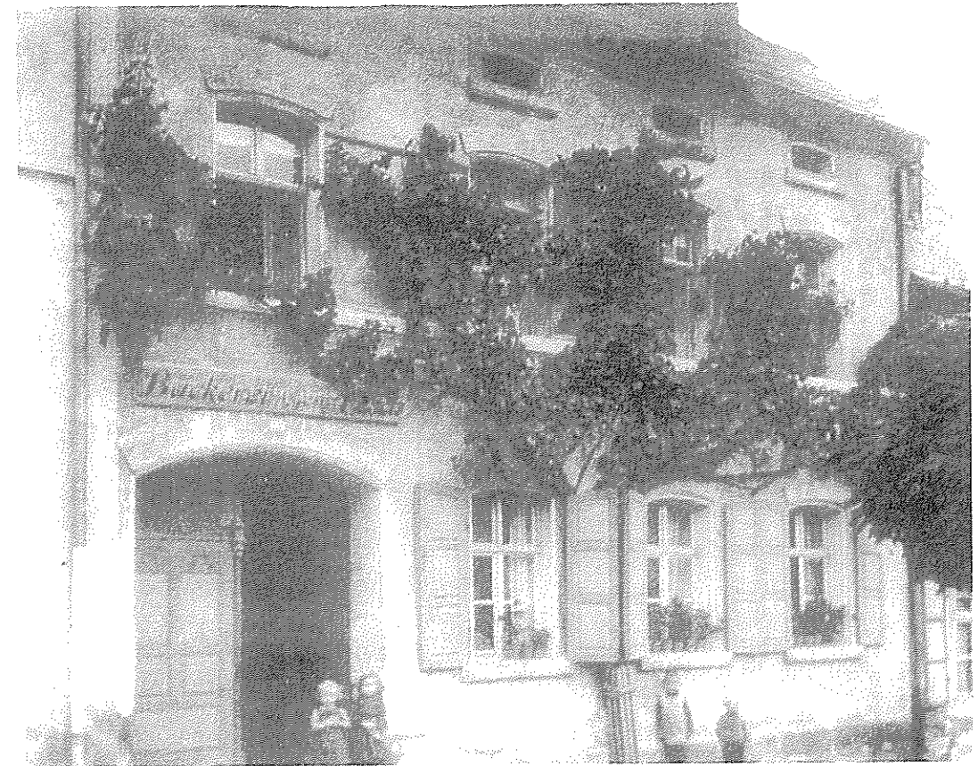
Klare Fassadengliederung mit vier Fensterachsen. Das Erdgeschoß wird betont durch das breite Durchfahrtstor und die Fensterläden.
