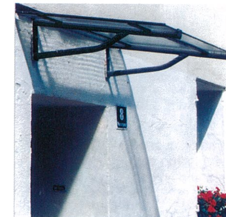
Das Anbringen von festen Vordächern über Eingangsbereichen am Karlsplatz und Marienplatz ist nicht erwünscht. Dagegen können in den Gassenbereichen kleinteilige Vordächer über Eingängen angeordnet werden. Möglich sind Holzkonstruktion mit Blech- oder Ziegeldeckung bzw. Stahl-Glas-Konstruktionen.
