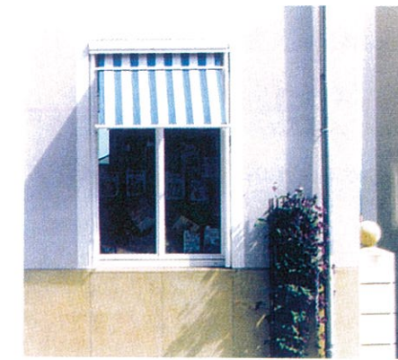
Ausfahrbare Markisen sind auf die Erdgeschoßzone beschränkt. Die maximale Breite einer Markise entspricht der des stehenden Schaufensters. Die Farbtöne sind dem Gebäude anzupassen und unterzuordnen.
