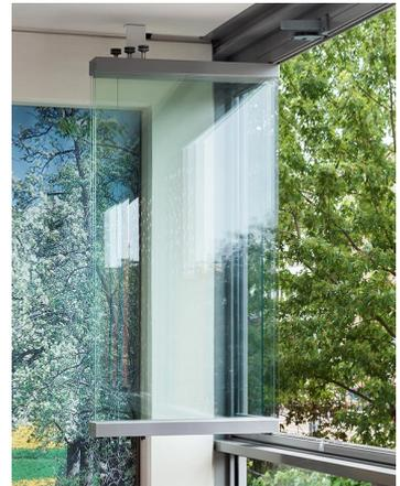
**Abbildung 2: Beispiel Balkonfassade, verglaste Loggia, Innenansicht /36/(mögliche Schallschutzmaßnahme gegen Verkehrslärmimmissionen)**
