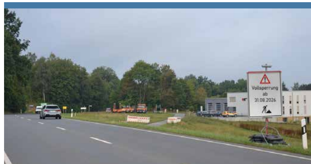
Die Straße zwischen Eschenbach und Grafenwöhr ist seit dem 31. August wegen einer aufwendigen Baustelle auf Höhe des Eschenbacher Rotkreuzhauses komplett gesperrt.
