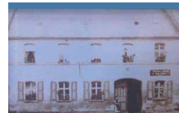
Bis in die 1960er-Jahre besaß das Anwesen die früher übliche Toreinfahrt. Rechts davon befand sich das Ladengeschäft, auf der linken Seite schlossen sich die Gaststätte und ein Nebenzimmer an.
