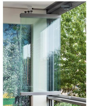
**Abbildung 2: Beispiel Balkonfassade, verglaste Loggia, Innenansicht /37/(mögliche Schallschutzmaßnahme gegen Verkehrslärmimmissionen)**
